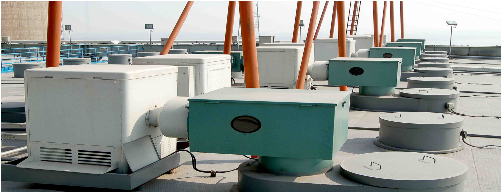
图 2 高频高压电除尘器电源图
