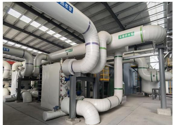
生供暖项目。电石炉循环冷却水系统目前经冷却塔散热，该部分热量直接散至空气中，造成大量工业余热浪费。现有循环冷却水系统出水温度较高，完全具备工业余热用于集中供热的温度条件，且热量产出过程实现“零排放”、“无污染”。同时通过机力通风间接空冷系统（间冷系统）建设，减少了软水消耗。
